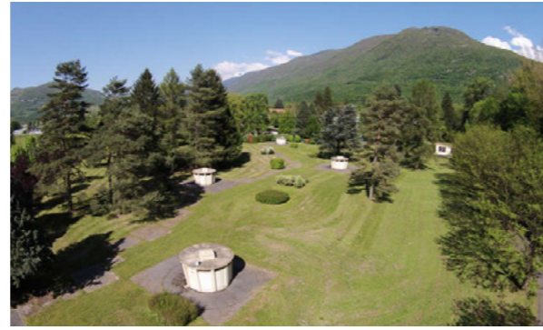
© Eaux de Grenoble Alpes Site de captage de Pré-Grivel
